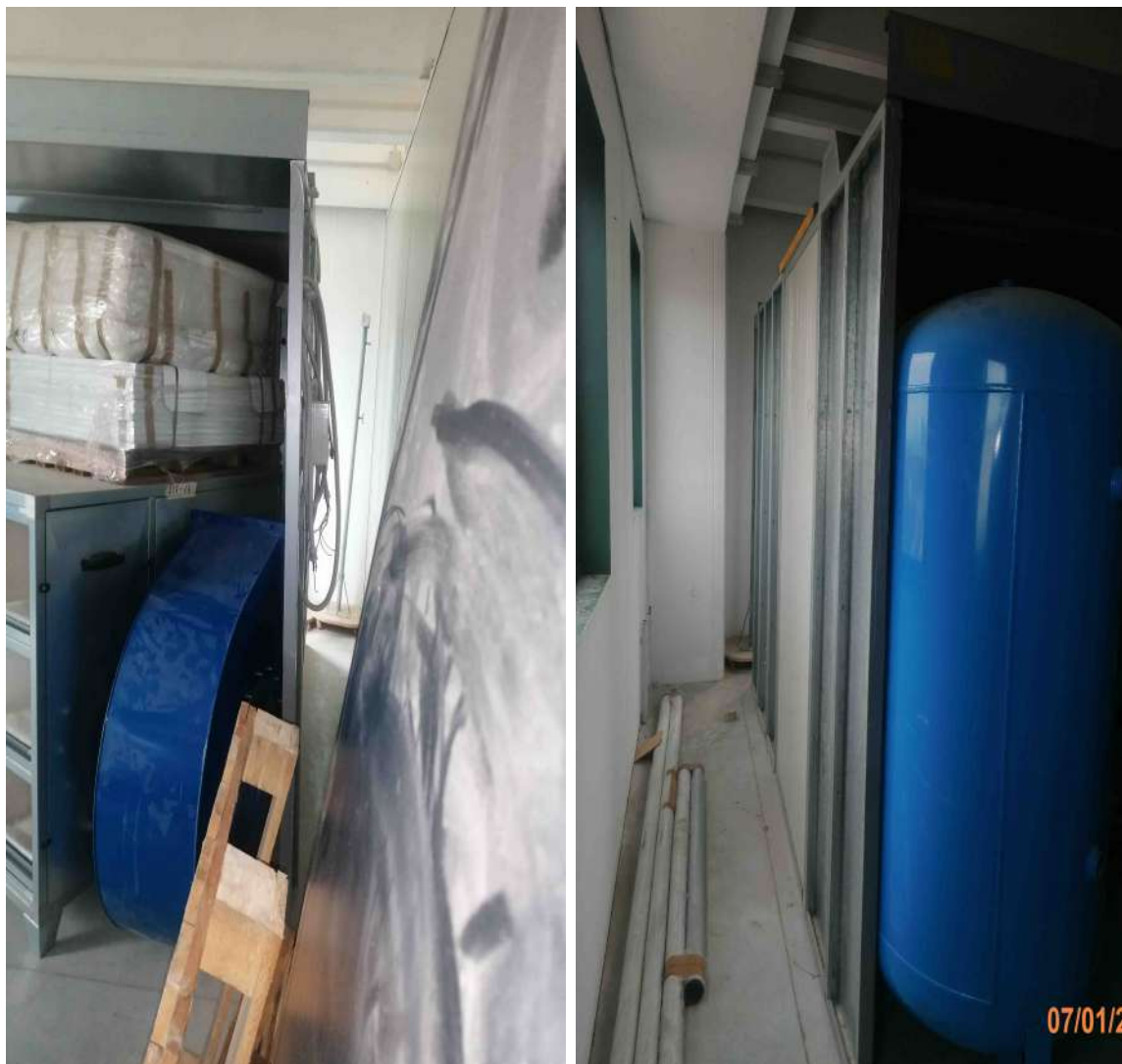
Pressurizzatore cabina verniciatura per stanza esistente composto da plenum con microfiltri “Cod. inventario M14”
