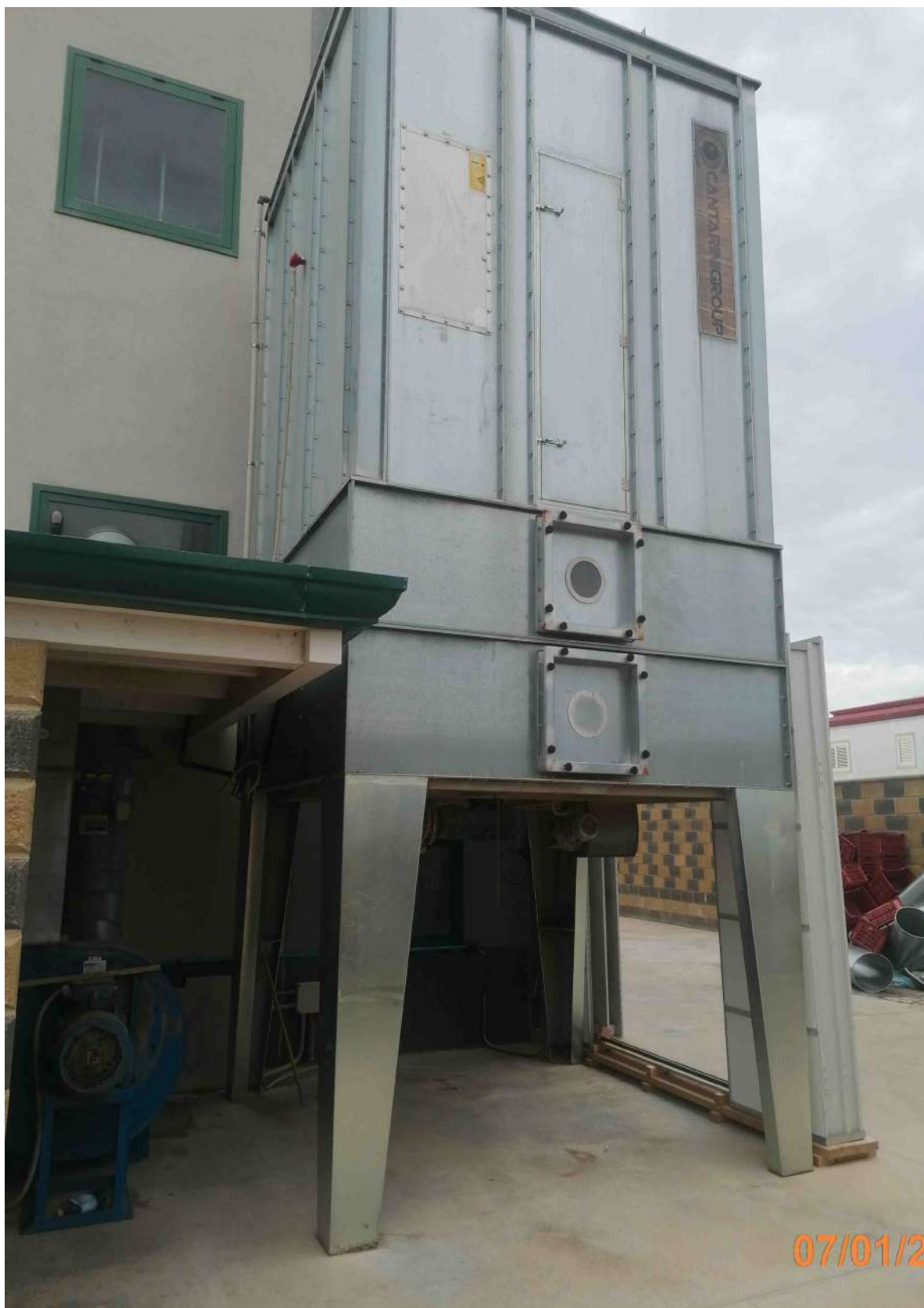
Impianto di aspirazione delle polveri Mod. PMSC Tipo 705 della Cantarinigroup “ Cod. inventario M15
