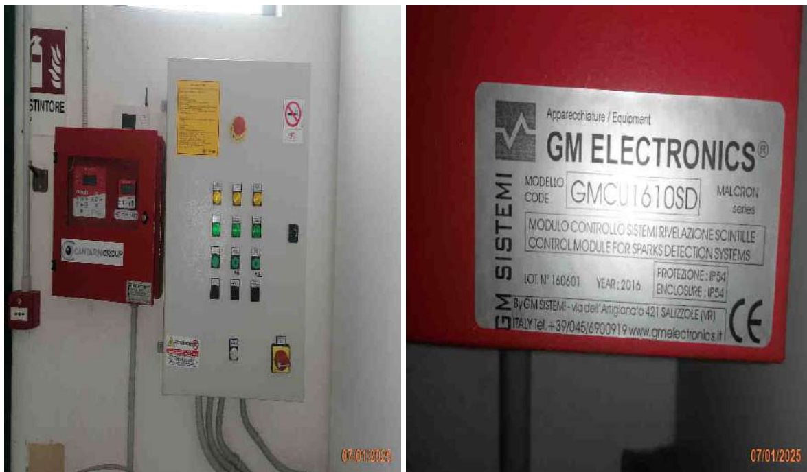
Quadro elettrico Impianto di aspirazione delle polveri Mod. PMSC Tipo 705 della Cantarinigroup “ Cod. inventario M15
